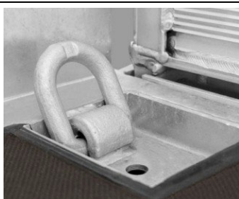
Sjorpunten verzonken in brugvloer
